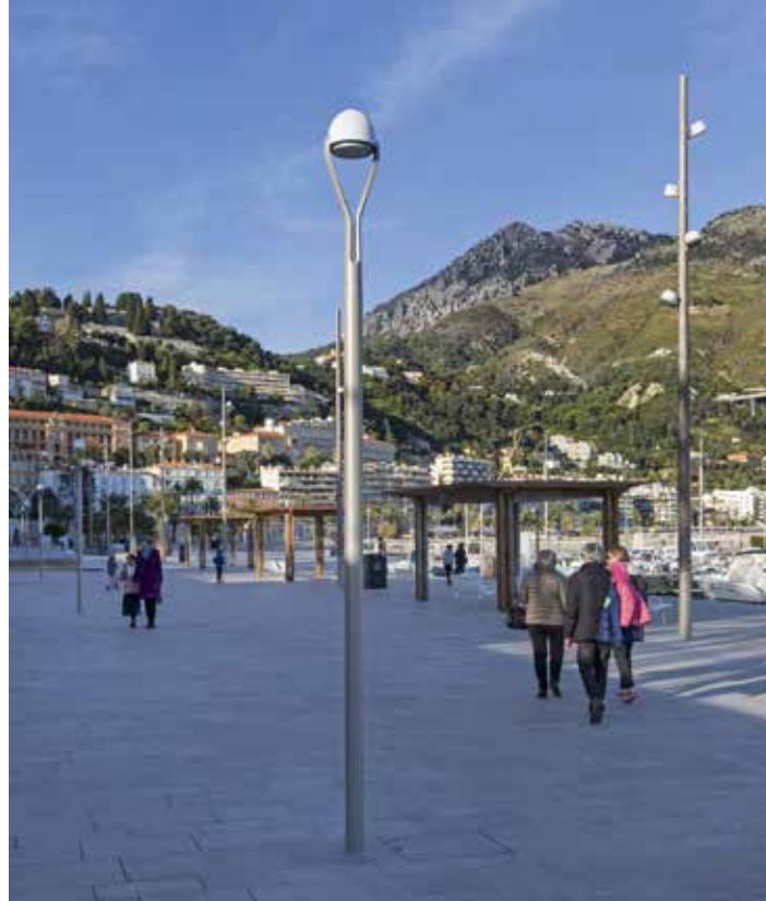
En toute sobriété, des mâts aluminium de 4 m de haut (Ceramic, modèle Juliette), équipés d'un luminaire LED et d'une coiffe en céramique, accompagnent les circulations piétonnes.
