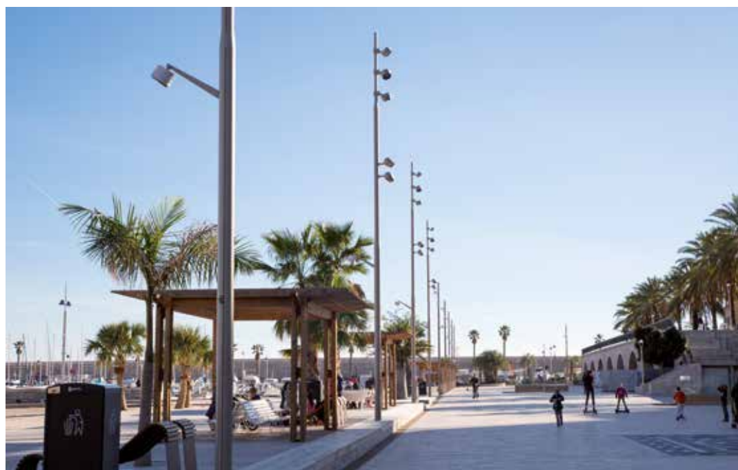
Sur l'esplanade, des mâts aluminium tri-section à LED de 14 m de haut assurent un éclairage doux à seulement 50 % de leur capacité initiale (soit environ 10 lux).
