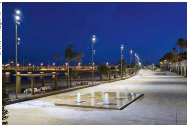
Ambiance nocturne fonctionnelle et douce le long de l'esplanade et du ponton en bois.
